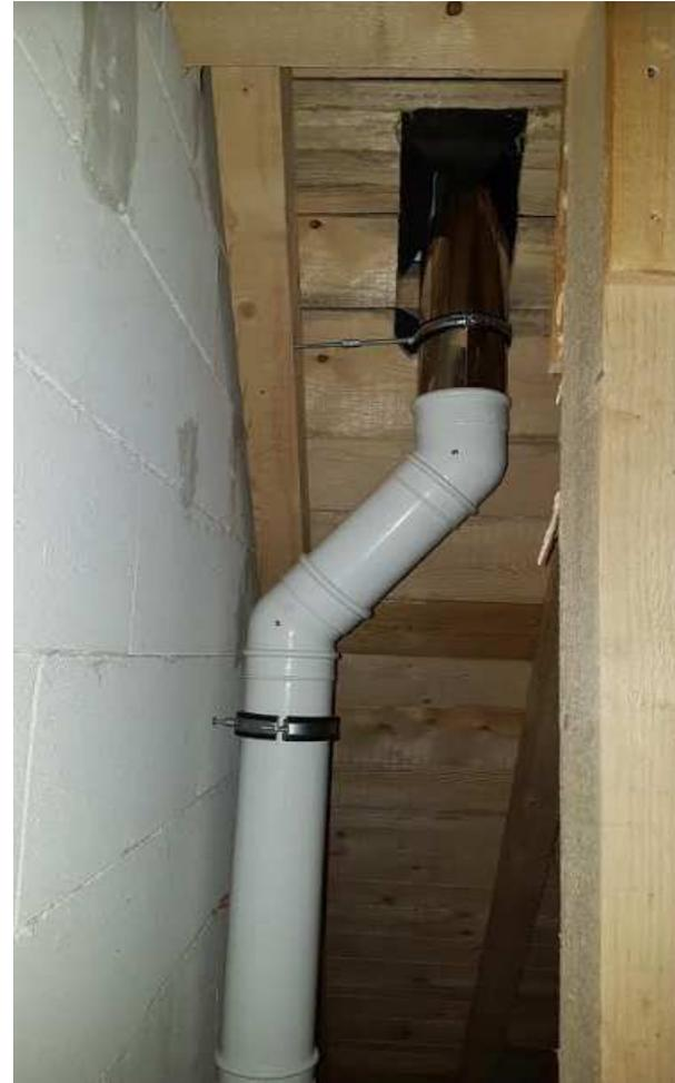
Abhängig von der Gebäudeklasse nach OIB Richtlinie 2, müssen konzentrische Systemabgasanlagen, entsprechend der brandschutztechnischen Bestimmungen, verkleidet werden.
