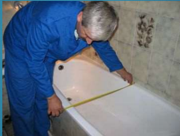
Maßnahmen für den passgenauen Zuschnitt der Wanne
