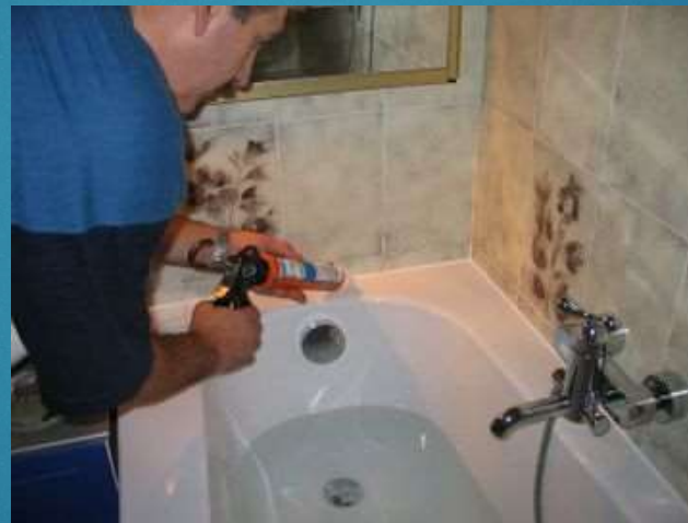
Montieren der Armatur und silikonieren der Wanne
