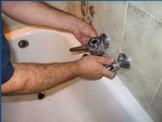
Demontage der alten Armatur
