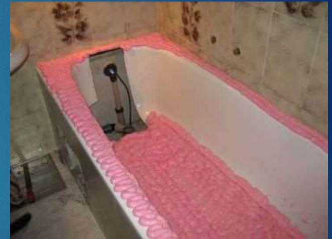
Einbau der neuen Ab-Überlauf- garnitur, Auftragen von PU-Schaum
