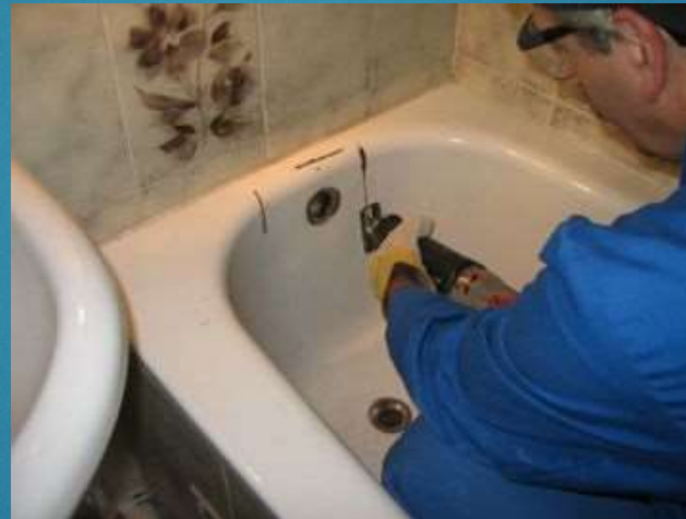
Aufschneiden der alten Wanne im Bereich des Ab-Überlaufs
