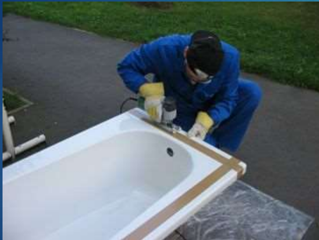
Zuschneiden der wand- anliegenden Seiten
