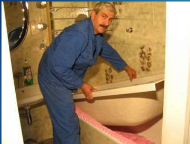
Einsetzen der neuen Wanne
