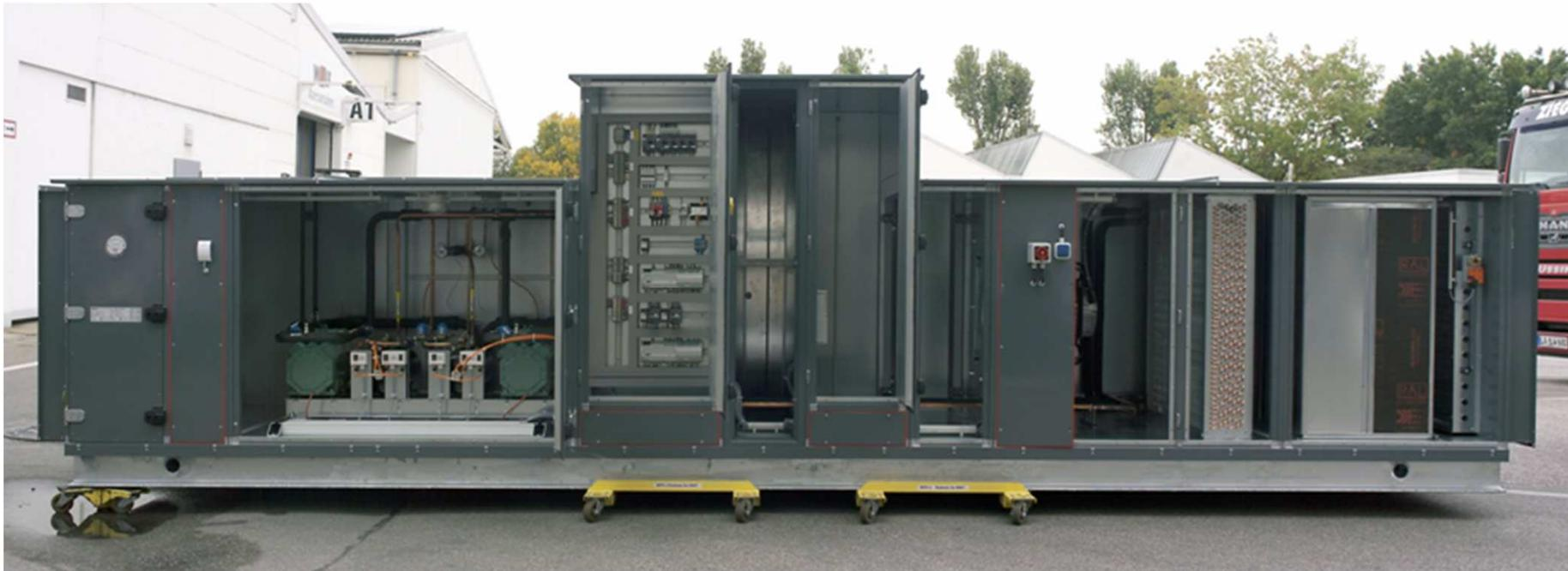
mit integrierter Kältemaschine und Rotationwärmetauscher
