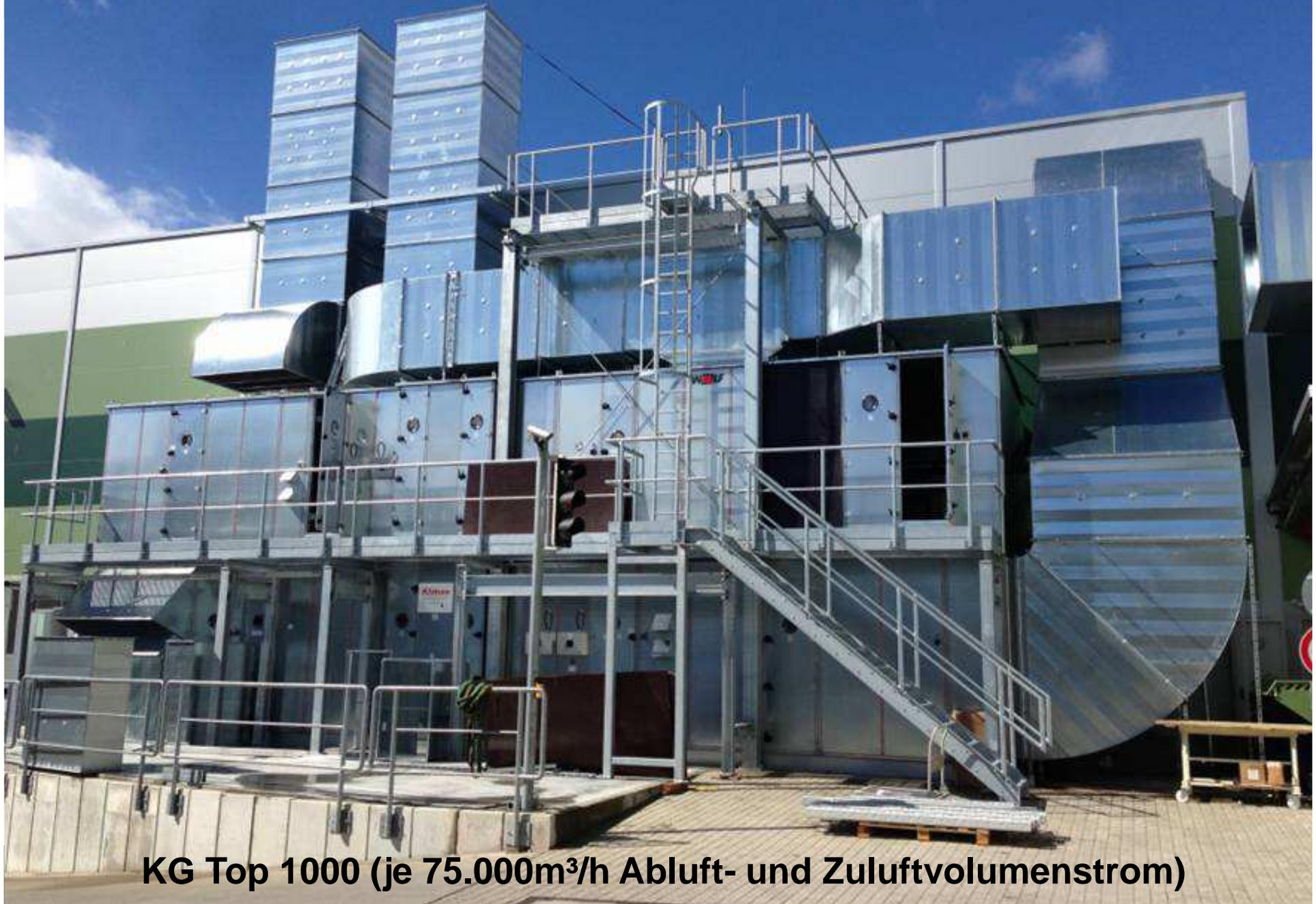
**KG Top 1000 (je 75.000m<sup>3</sup>/h Abluft- und Zuluftvolumenstrom)**
